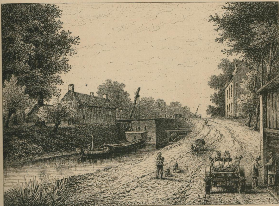
CONSTRUCTION DU NOUVEAU PONT DE VILVORDE.
